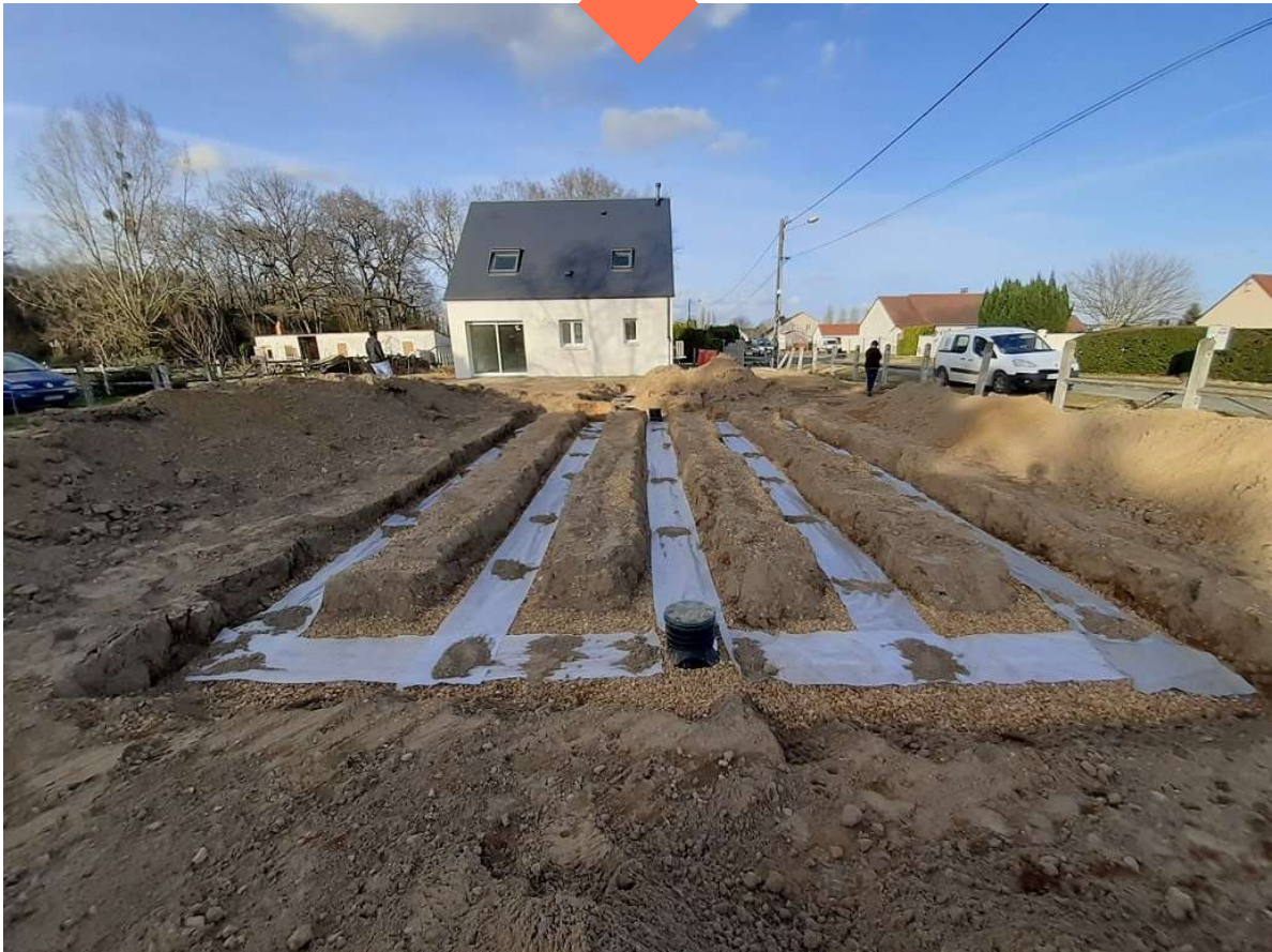
Installation d'ANC chez un particulier - Source : SATESE 37
