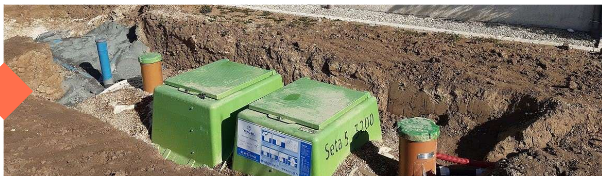
Installation d'ANC chez un particulier - Source : SATESE 37
